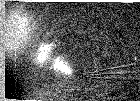
写真-1 盤膨れ・支保工破壊(DII-7-B-P)
