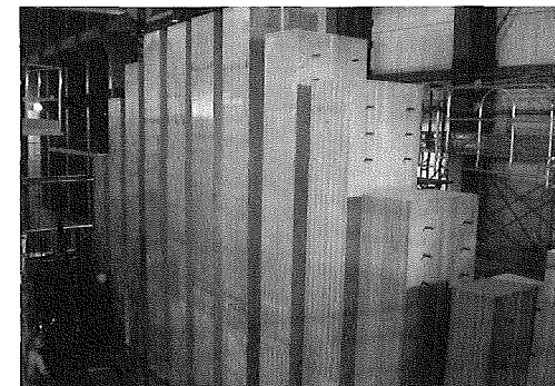
写真はSEW工法施工例
