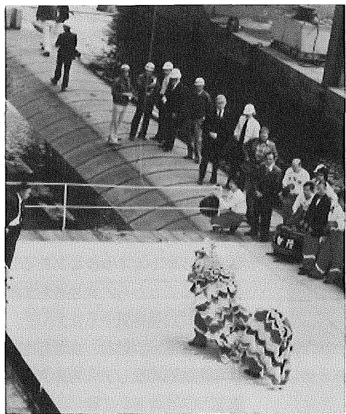
香港地下鉄103工区 最終函沈設前の式典状況
