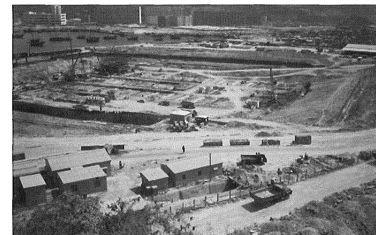
香港地下鉄103工区ドライドックの全景
