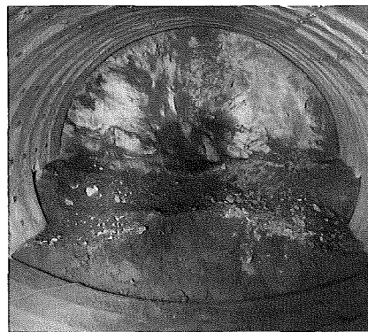
写真は早期閉合状況
