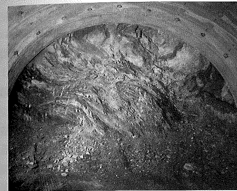
写真-1 STA.490+74切羽状況
