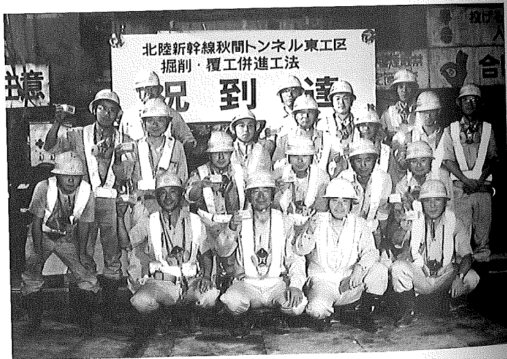
北陸新幹線秋間トンネルECL区間到達
