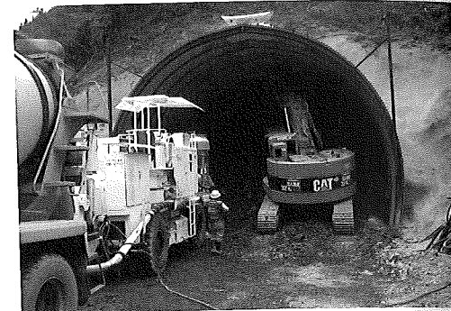
写真-2 吹付け併用掘削状況
