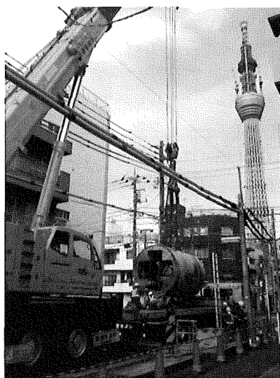
写真-8 シールド回収状況
