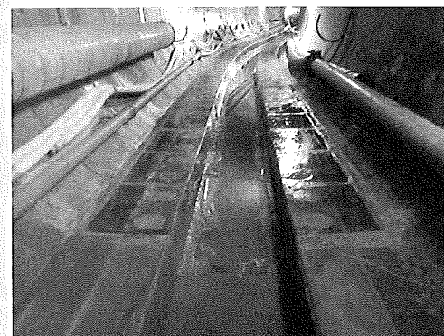
写真-5 特殊急曲線用セグメント(II型)インバートブロック
