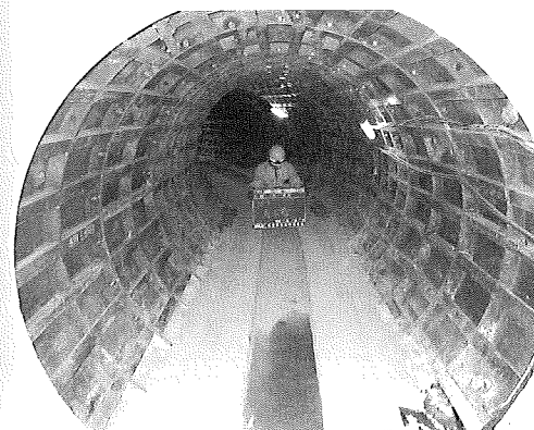
写真-4 鋼製セグメントインバートブロック
