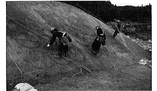
写真-5 客土工の施工状況
