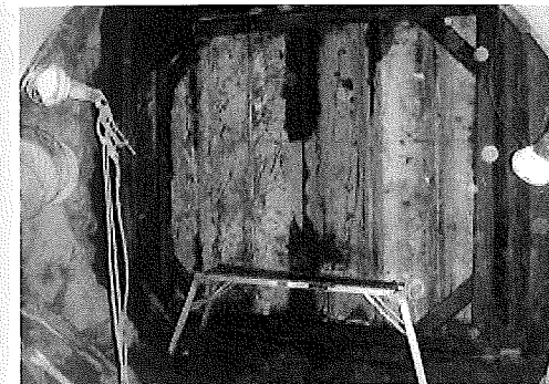
写真-2 開口部補強
