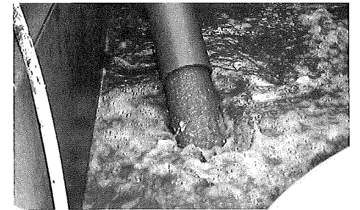
写真-3 濁水原水の状況
