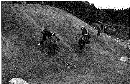
写真は客土工の施工状況
