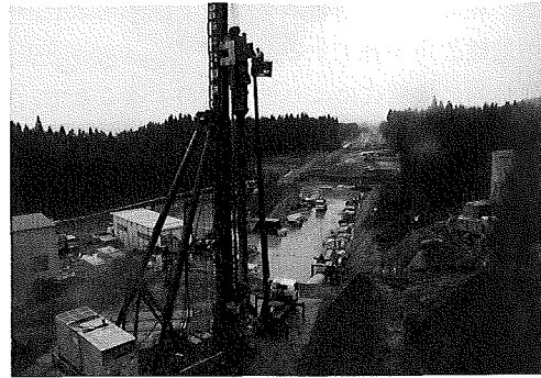
写真-2 トンネル坑口側部地盤改良施工状況
