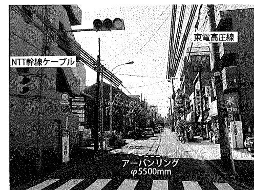
写真-7 到達立坑施工場所
