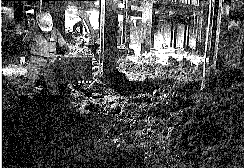
写真は掘削状況
