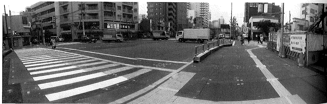
写真-1 路面覆工設置状況
