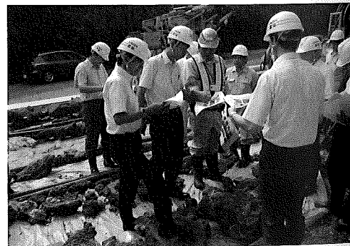
写真-3 眉山トンネル工事施工監理委員会実施状況
