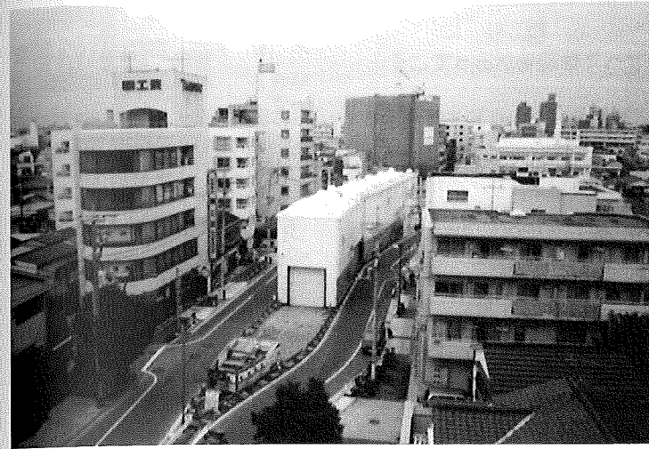
路上立坑基地全景(省面積立坑システム)
