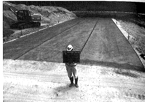
写真-6 盛土補強材とソイルセメント
