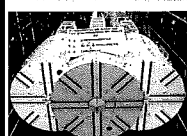
1995 (90円泥水式駅シールド) 地下鉄12号線環状部飯田橋駅 工区建設工事で活躍
