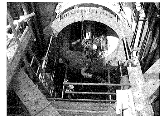
写真-1 呼び径3500超大口径管推進工事
