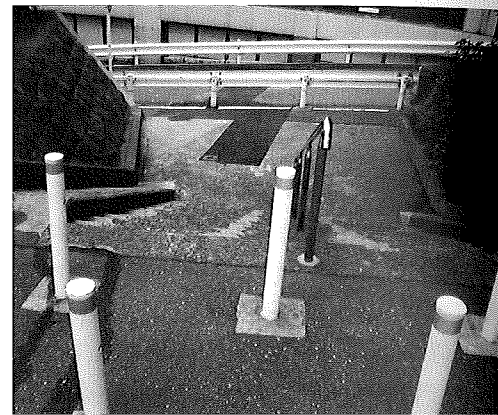
写真-1 TNo.1立坑周辺
