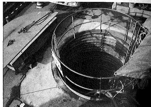
写真-5 発進立坑
