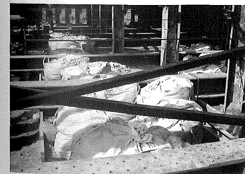
写真は掘削箇所への上載荷重に大型土嚢を載荷した状況
