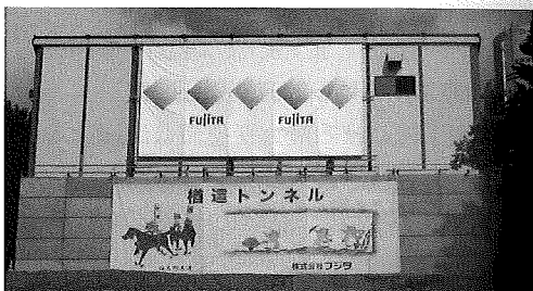
楢道トンネルバッチャープラント裏
