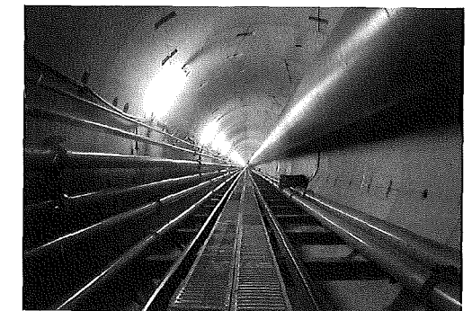
写真-13 トンネル坑内状況(川越側3,500m地点)
