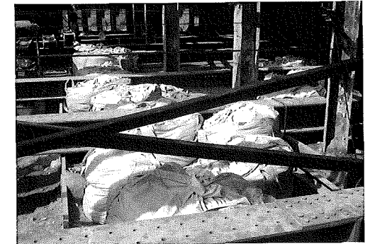
写真-1 大型土嚢載荷状況写真
