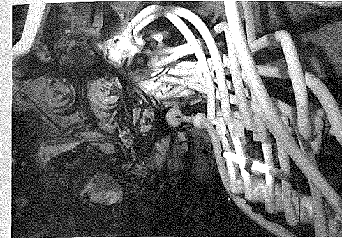
写真-15 凍結時シールド内の状態(川越側)
