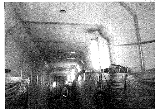
写真-9 充填状況
