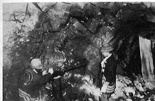
昭和10年代の削岩機(丸太がサポーター代わり)
