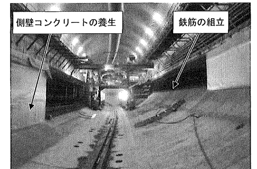
写真-1 シールド掘進後方での床版・側壁の構築状況
