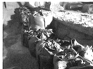
写真-4 大型土のう設置状況
