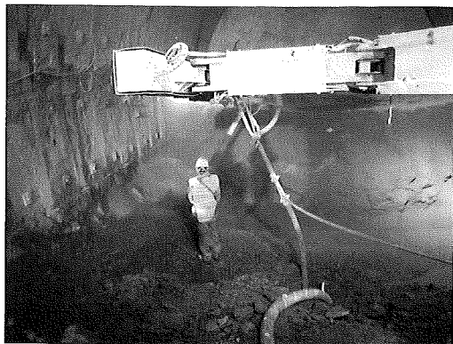
(a) 吹付けコンクリートによる一次インバート
