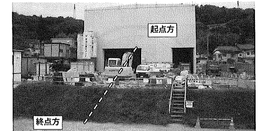
写真-1 防音ハウス
