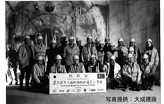
写真提供：大成建設
