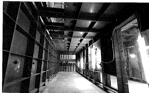
写真-4 鋼殻切断状況(底板, 側壁部)
