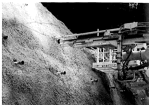
(施工例)鏡面への小口径二重管削孔システム
