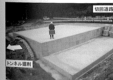
写真はRCスラブのコンクリート打設完了
