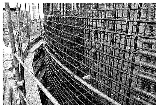
写真-1 CFRPロッド
