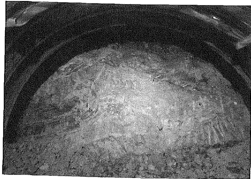
写真-2 切羽写真(14km430m)
