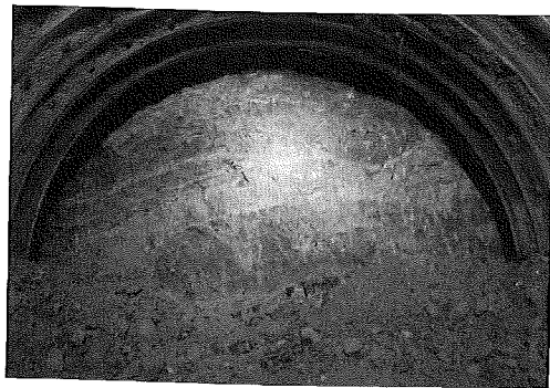
写真-3 切羽写真(14km438m)
