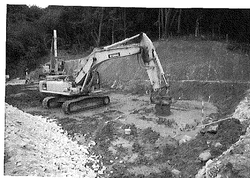
写真-1 トンネル側壁部の地盤改良工
