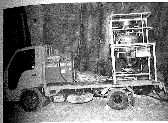
アンホローダ(金勝山トンネル)
