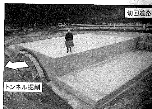
写真-4 RCスラブのコンクリート打設完了
