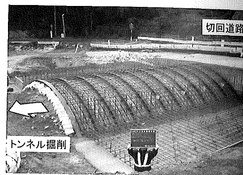
写真-3 RCスラブの鉄筋組立て
