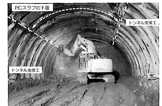
写真-8 RCスラブ直下のトンネル掘削状況
