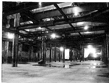
写真-3 掘削完了状況
