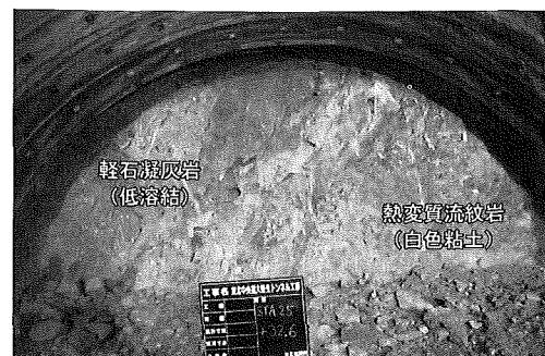
写真-2 変状区間Aの切羽
