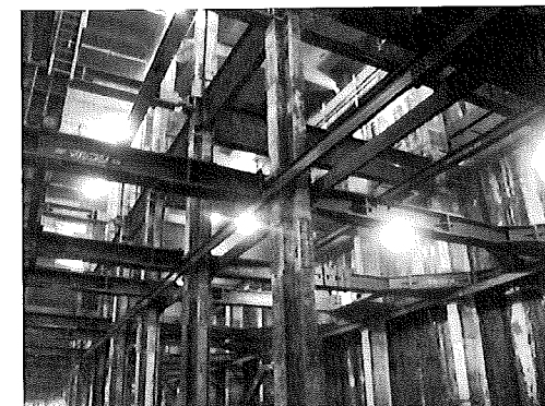
写真-5 土留め支保工設置状況
