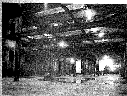
写真は掘削完了状況
