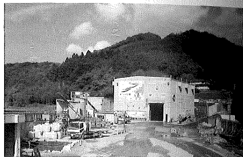
起点側横坑坑口(防音ハウス)
