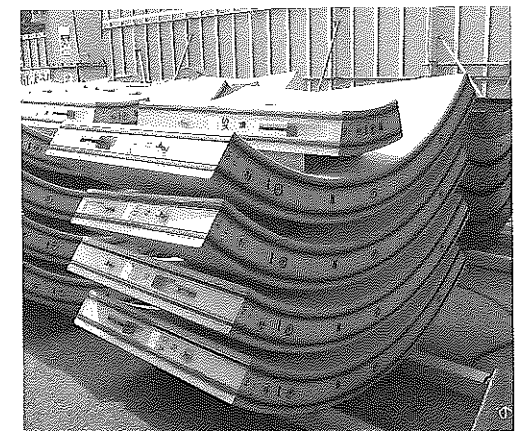
写真-3 シール材2段の施工
