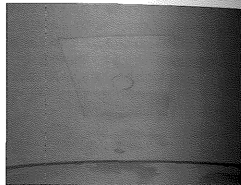
写真-6 仕上がり状況
