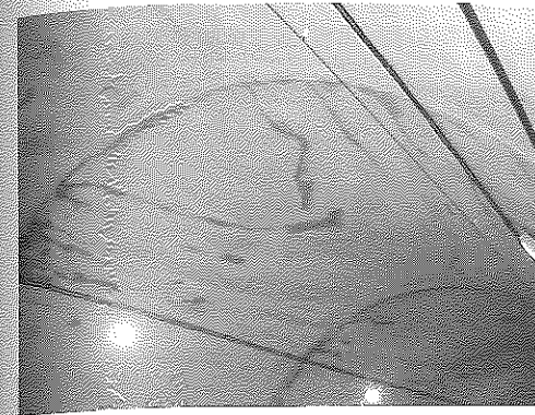
写真-12 標準工法(竹割縞模様)
