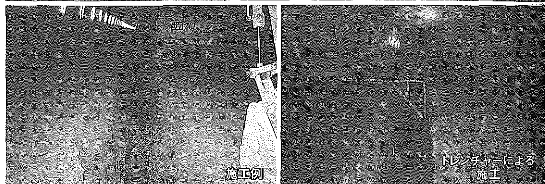
トンネル中央排水路掘削状況
