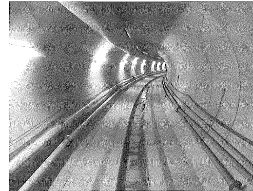
写真-8 RCセグメントR=100m曲線部
