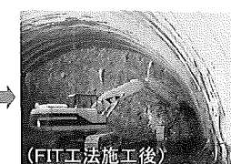
(FIT工法施工後)
