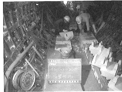
写真-7 インバートブロック設置状況
