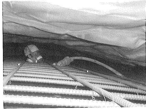
写真-5 従来の覆工施工状況
