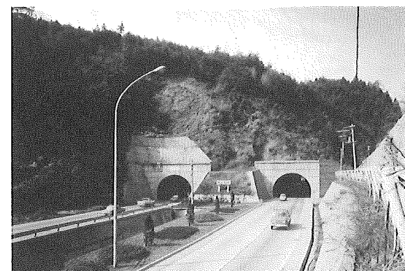
東山トンネル坑口(坑口の崩落)
