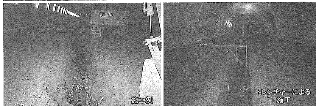
トンネル中央排水路 掘削状況
