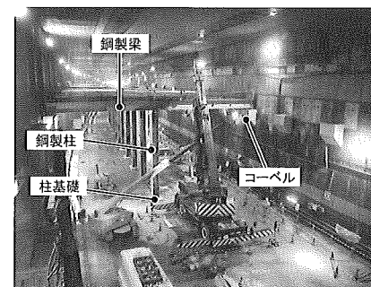
写真は鋼製梁・柱の架設
