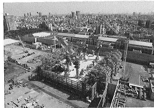
写真-3 躯体構築状況
