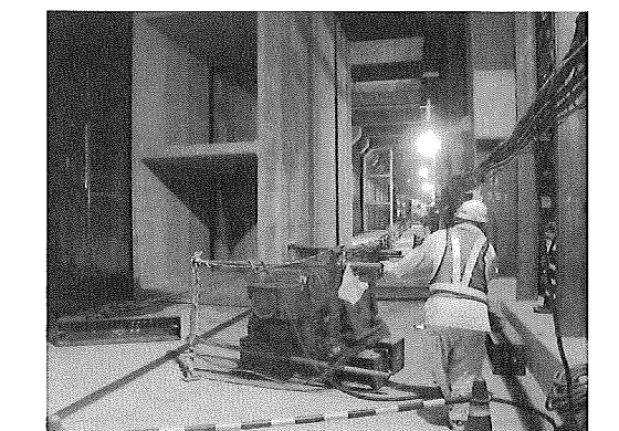
写真-9 ボックスカルバートの横引き
