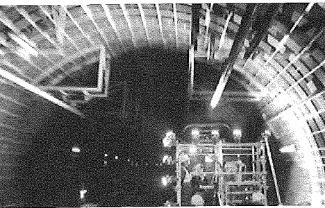
写真-2 トンネラスキャナーによる撮影状況 3)
