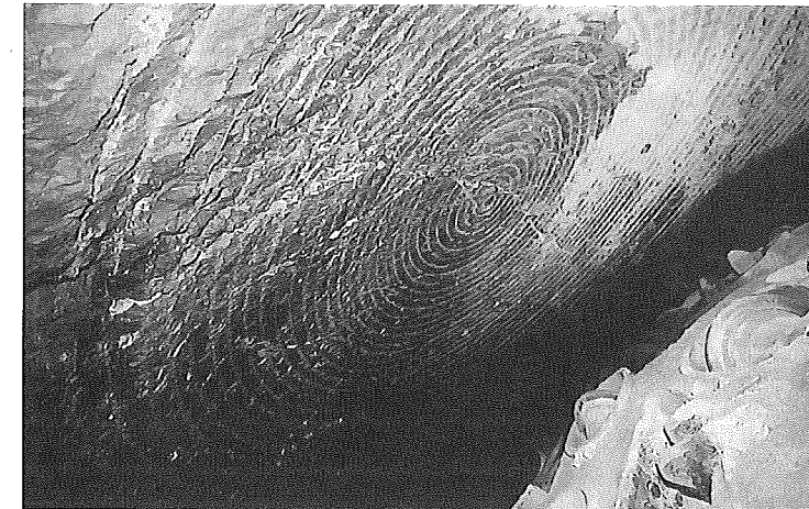
神流川斜坑切羽のカッター軌跡
