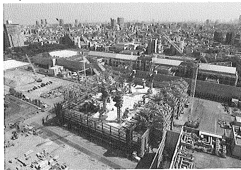
写真は躯体構築状況
