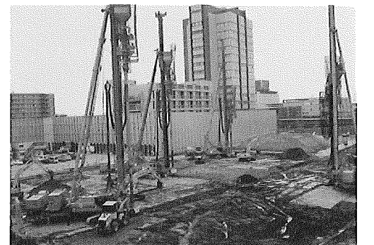
写真-1 地盤改良状況
