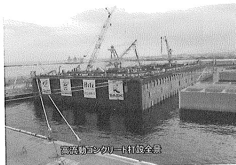
写真は浮遊状態での高流動コンクリート打設状況
