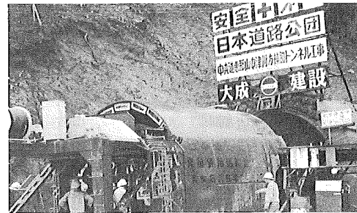
写真-5 坑口の上に置かれた社 4)
