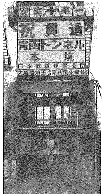
青函トンネル立坑(吉岡工区)
