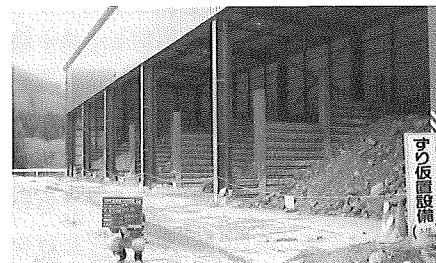
写真-1 ずりの仮置き場：二次判定待ち(雪沢第一トンネル)
