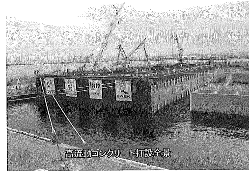
写真-3 浮遊状態での高流動コンクリート打設状況
