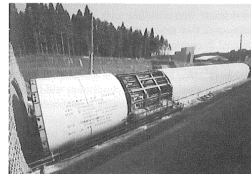
写真は津軽蓬田トンネル坑口部
