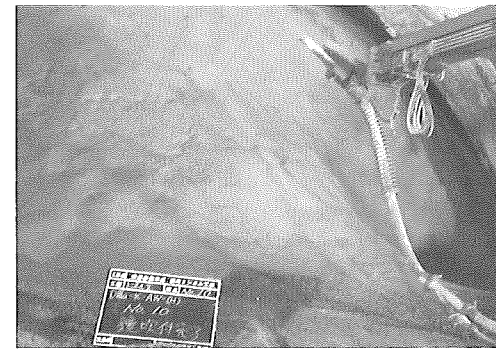
写真-5 高強度吹付け状況
