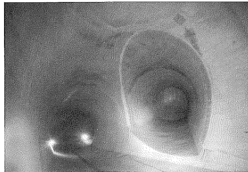
写真は本坑・分岐坑取合部
