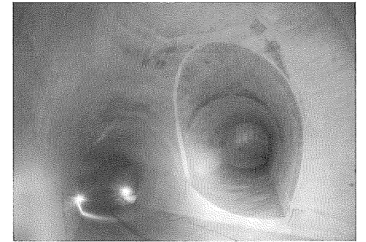
写真-4 本坑・分岐坑取合部
