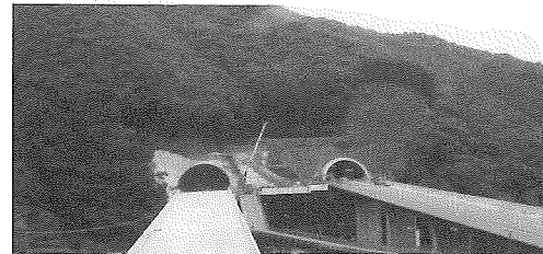
島田第一トンネル上下線を西坑口より望む
