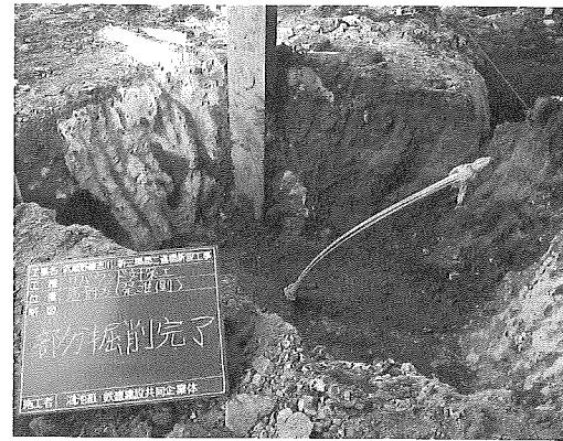
写真-4 部分掘削状況
