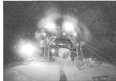
写真-2 移動式スライドセントル
