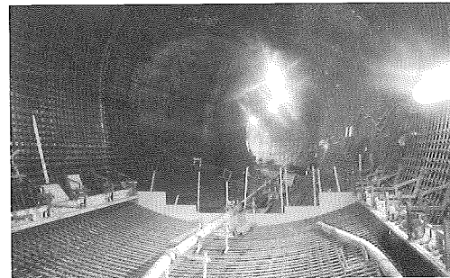
写真-1 インバートコンクリート施工状況
