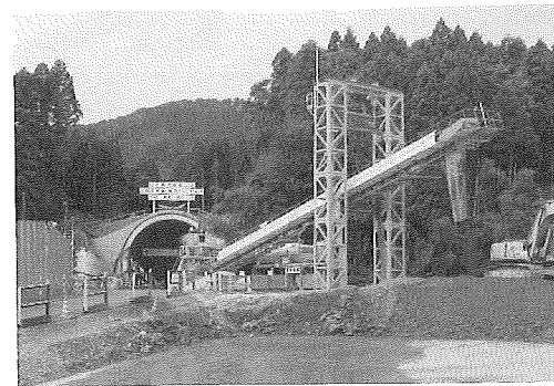
写真-6 仮置き場全景(連続ベルトコンベヤ方式)
