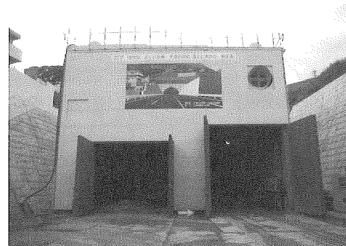
写真-2 ずり仮置き場(防音ハウス内)全景
