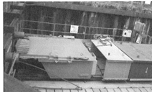
写真-6 刃口・模擬エレメントの状況
