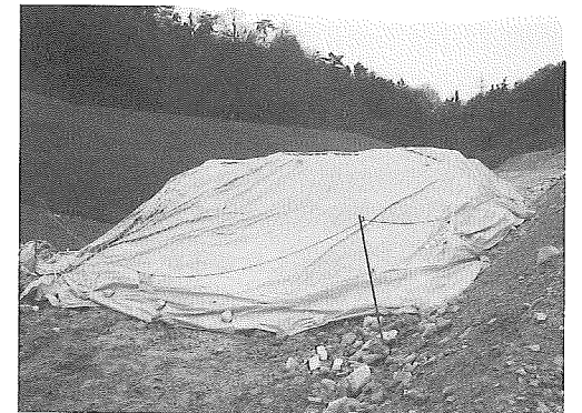
写真-12 研究所用地内堆積場(シート養生)
