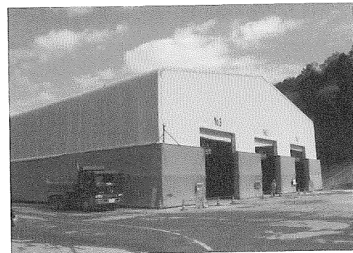
写真-14 ずり仮置き場全景(専用テント)
