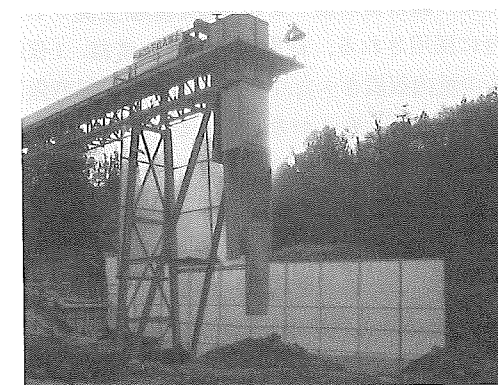
写真-9 防じんネット設置状況
