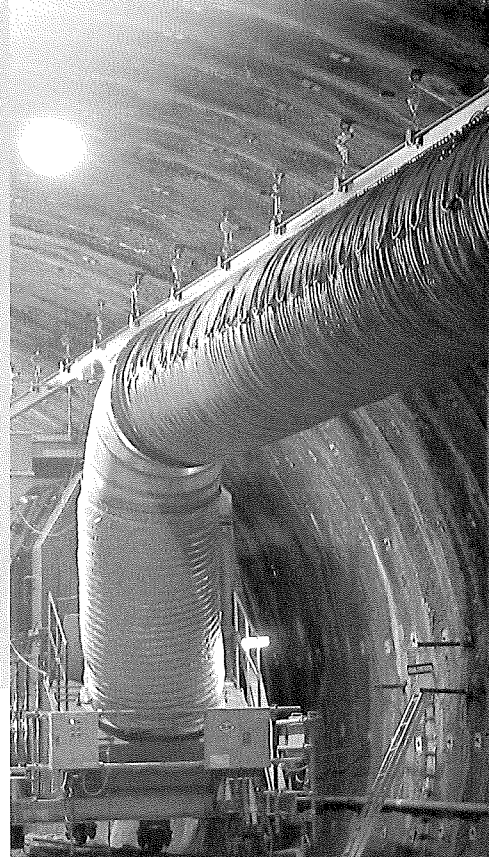
大型集塵機 1000～4000m 3 /min 30000hメンテナンス フリー。トンネル 用は清浄度0.1mg/ m 3 以下保証
