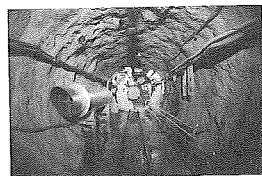
写真は完成した天然ガス高圧貯蔵実証試験施設
