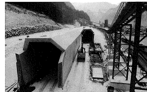
写真は北坑口の明かり巻き状況
