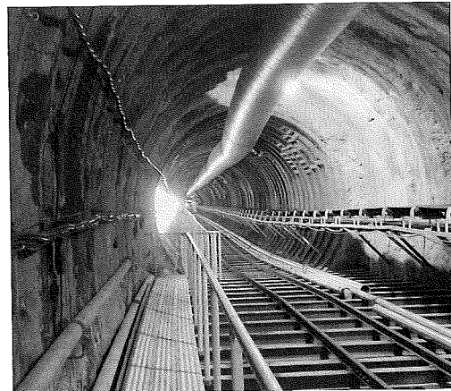
写真-10 TBM掘削における設備(坑内)
