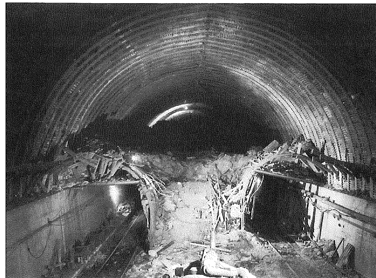
上越新幹線 中山トンネル(左:従来工法, 右: NATM)
