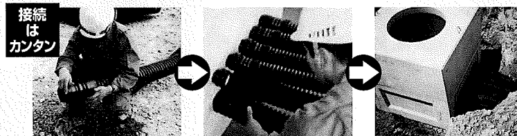
管路に継手差口をねじこみ 継手受口に差しこむだけ これで接続完了。
