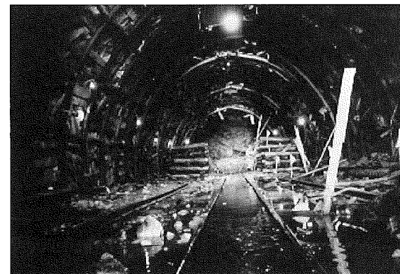
映画『黒部の太陽』で用いた破砕帯直前のトンネルと大出水の装置。(株)熊谷組豊川工場内に模擬トンネル(実物大、当時現地で用いた支保工を使用)を作成して撮影が行われました。
