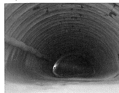
写真は上半仮インバート
