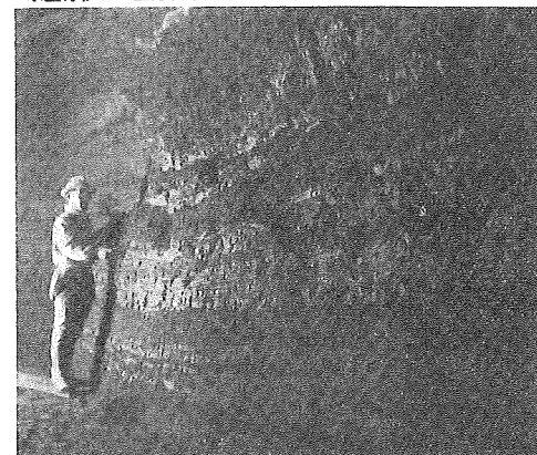
第74圖 西口7,392呎附近土平泥岩黒砂互層状態
