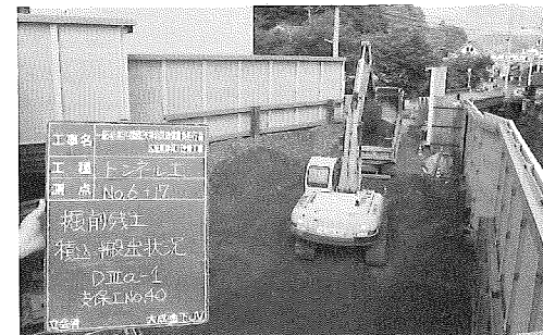
写真-3 ずり仮置き場での積み込み状況 1)
