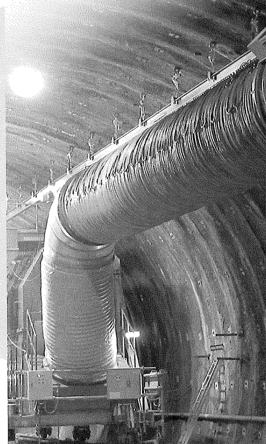
大型集塵機 1000~4000m 3 /min 30000hメンテナンス フリー、トンネル 用は清浄度0.1mg/ m 3 以下保証
