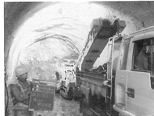
写真-2 ずり積み状況 1)
