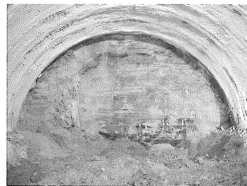
写真-2 鈴田トンネル(39km215m)の切羽状況
