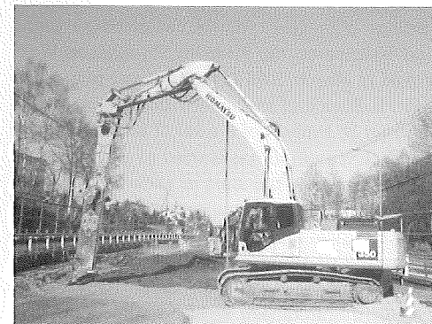
写真は国道交差点における地山改良工状況
