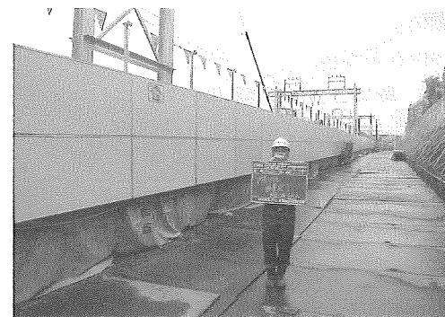
写真-4 工事桁下脇を防音シートにて閉塞
