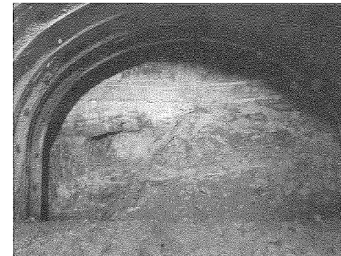
写真-1 俵坂トンネル(斜路308m地点)の切羽状況
