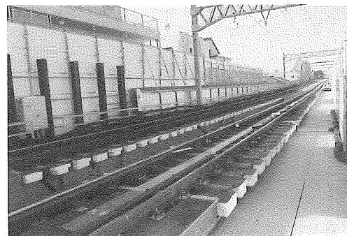
写真-8 ポリエステル吸音材設置完了
