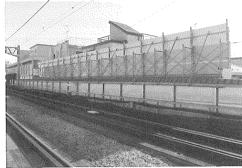
写真-5 防音パネルの嵩上げ
