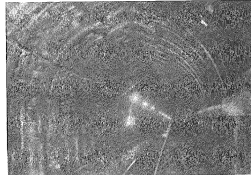
写真-1 支保工設置状況
