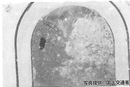
亀の背トンネル発見時の排水トンネルの切羽
