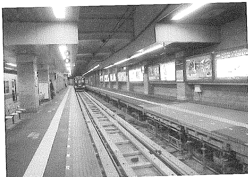
写真-2 駅構内施工状況写真
