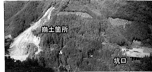
坑口と崩土箇所
