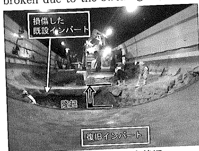
写真は緊急復旧工事状況
