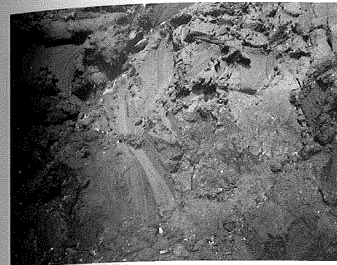
写真-4 切羽面の状況
