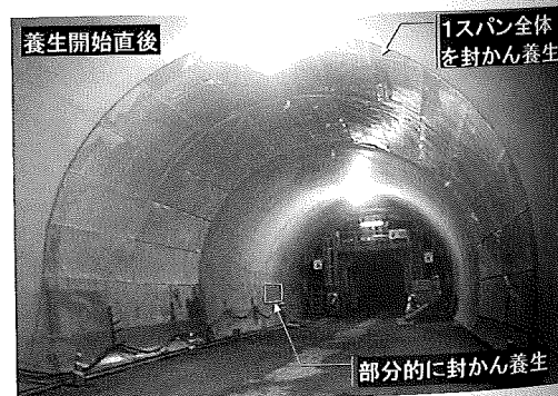
写真-1 プラスチックフィルム封かん養生の実施状況
