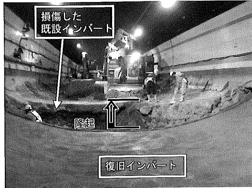
写真-1 緊急復旧工事状況
