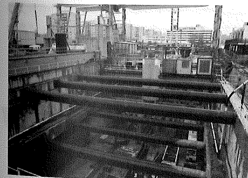
写真-4 ブダペスト地下鉄・土留め連壁の切梁鋼管
