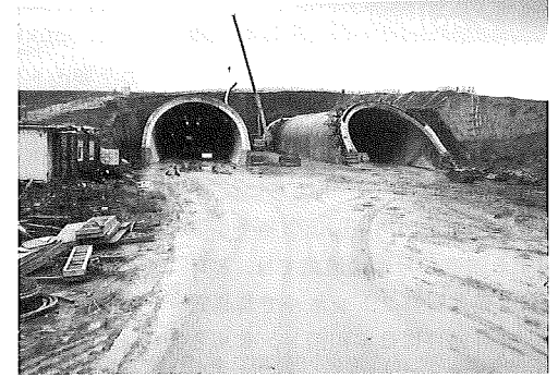
写真-9 M6トンネル・竹割り式坑門工
