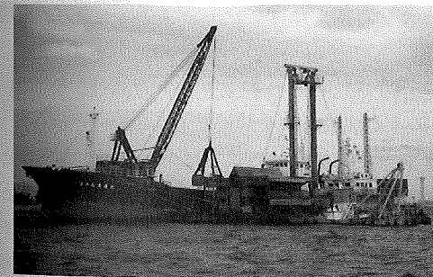
写真-5 基礎石投入(トレミー方式)
