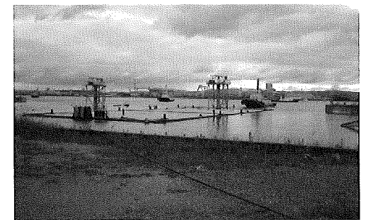
写真-7 一次曳航(ドックアウト)
