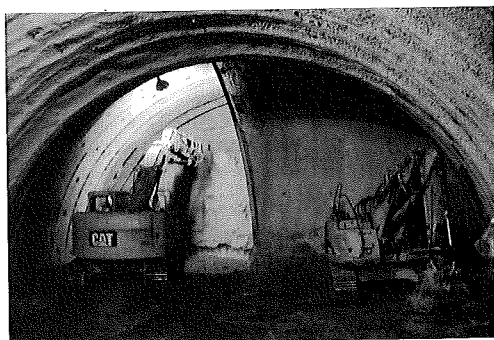
写真は駅大断面区間掘削状況
