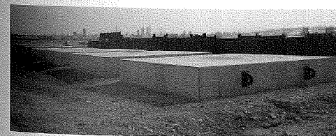
写真-6 仮支承台(直接基礎形式)
