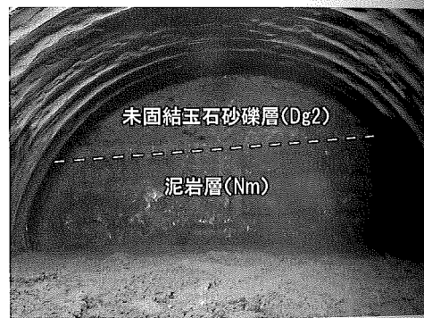
写真-2 切羽写真(破線：地層境界)
