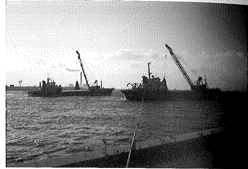
写真-16 ガット船による埋め戻し
