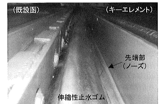
写真-24 伸縮性止水ゴム圧縮状況
