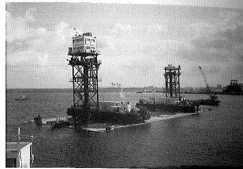
写真-11 沈設工(タワーポンツーン方式)
