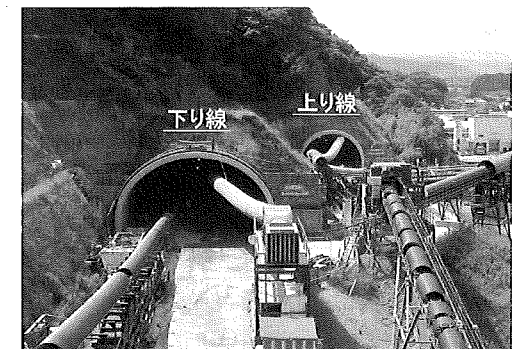
写真-1 南側坑口
