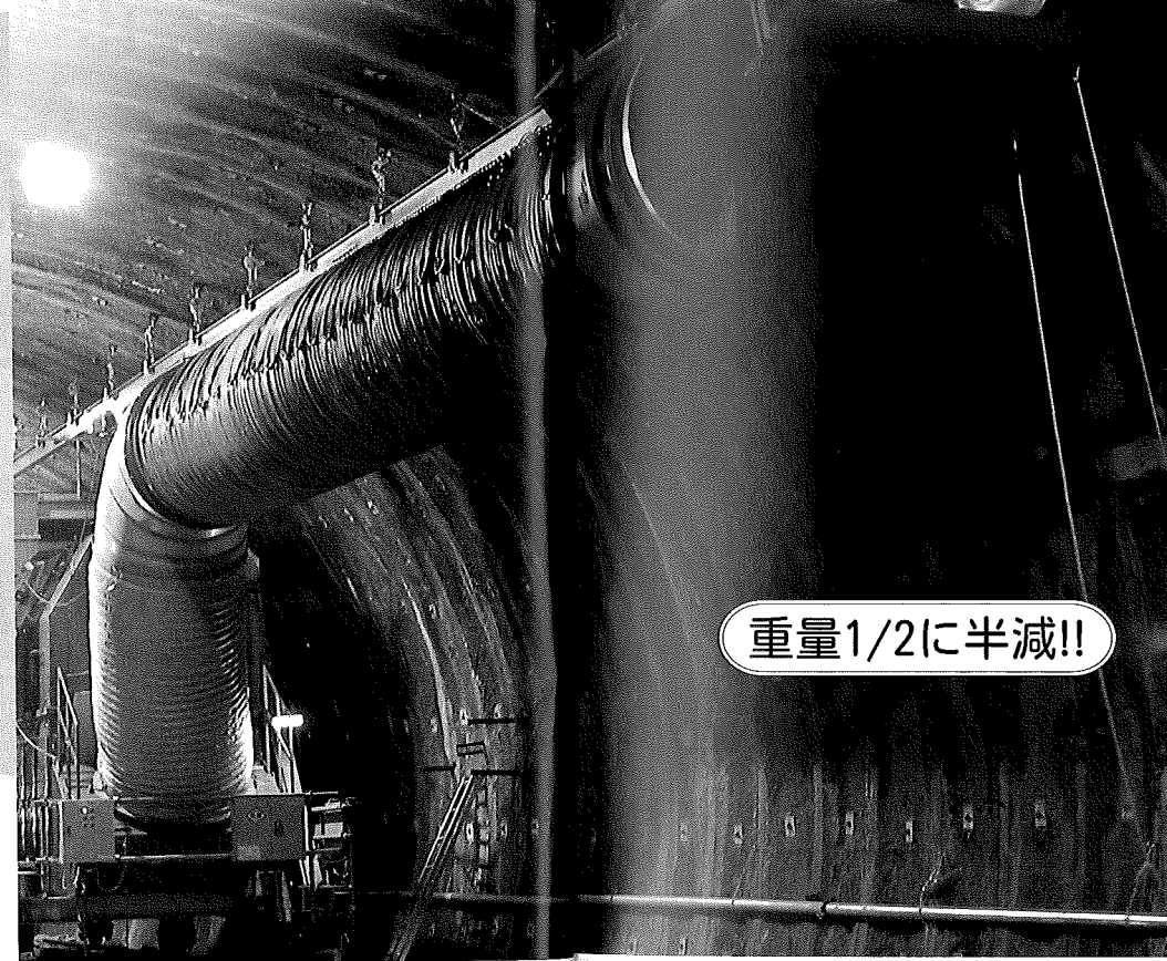
大型集塵機 1000～4000m 3 /min 30000hメンテナンス フリー、トンネル 用は清浄度0.1mg/ m 3 以下保証
