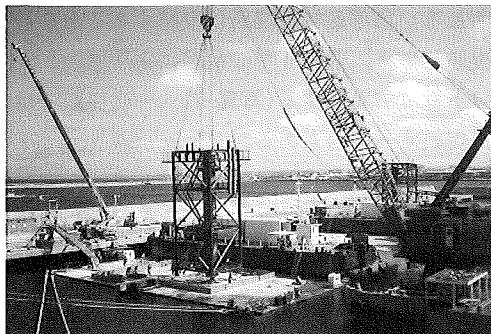
写真-9 二次艀装(ウインチタワー設置)
