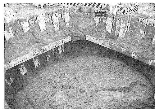
写真-8 脱水ベルコン未使用の排土状況
