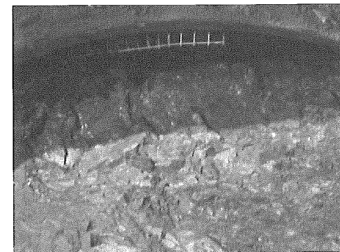
写真-3 切羽拡大写真(鏡肌の発達)
