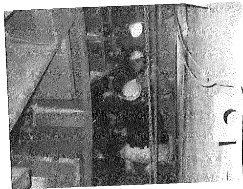
写真-4 ビット交換状況
