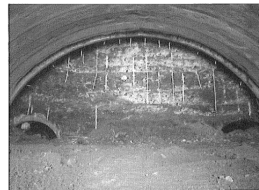
写真-3 トンネル上半切羽状況写真
