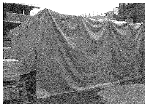
写真-7 防音シート(吸引装置)
