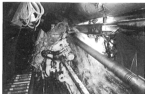
写真-7 先進ボーリングからの大量湧水
