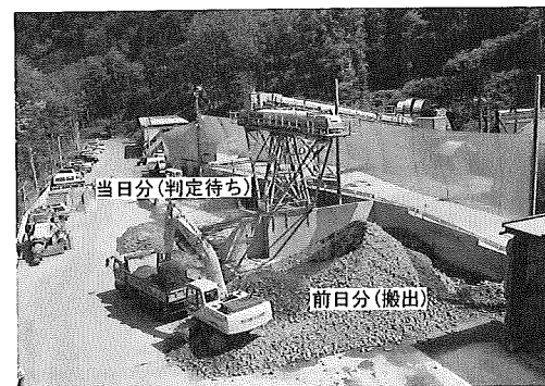
写真-1 坑口ずり仮置き場
