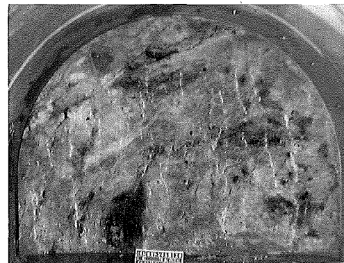
写真-4 注入完了後の切羽状況(フェノールフタレインにより着色)
