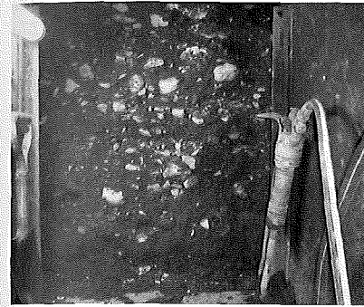
写真はJESエレメント挿入時の切羽状況
