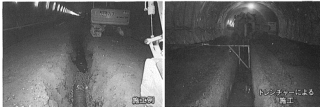
トンネル中央排水路 掘削状況
