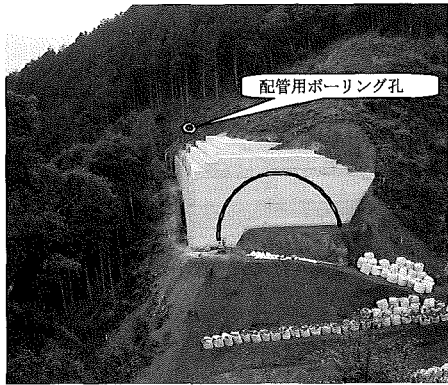
写真-6 和田TN東坑口FCB完成状況
