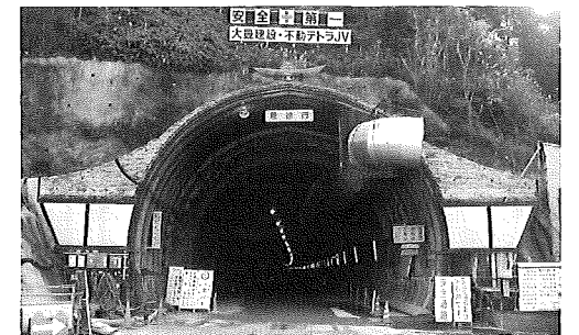
トンネル坑口
