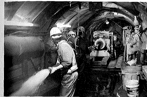
写真-3 水抜き坑からの長尺ボーリング
