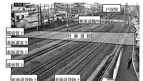
写真-2 施工箇所全景(東京方より)
