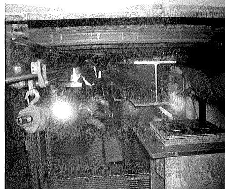
写真-6 下受け桁の施工状況
