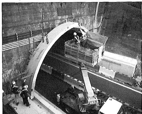
写真はプレキャストアーチ部材架設状況
