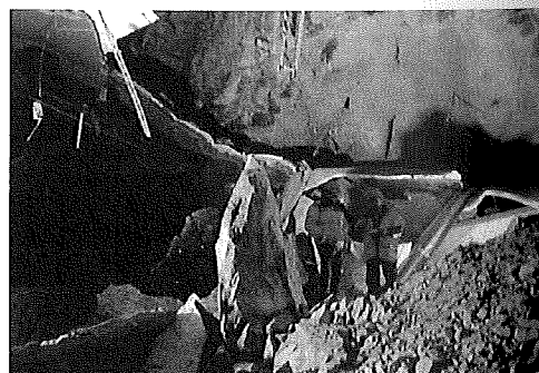
写真-1 Hanekleiv トンネル崩壊状況
