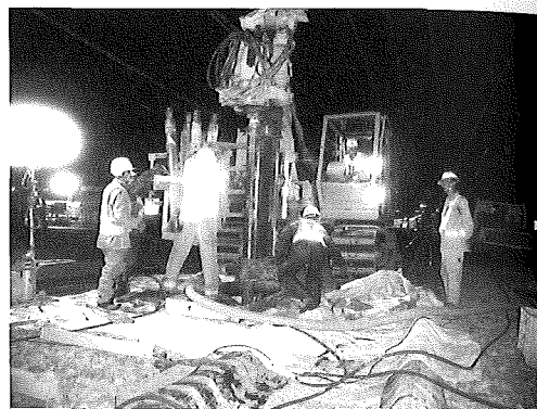
写真-3 遮水壁工・沈下対策工
