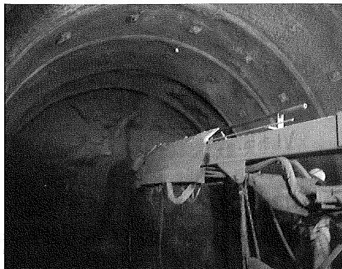
写真-2 スラリー状急結剤吹付け状況
