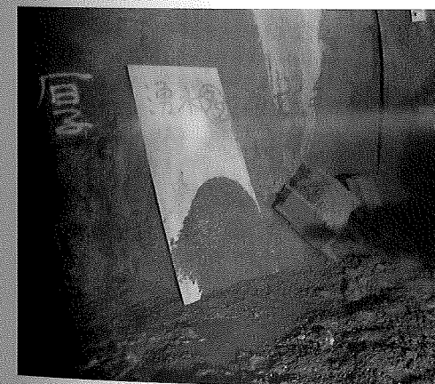
写真-3 湧水対応性確認状況
