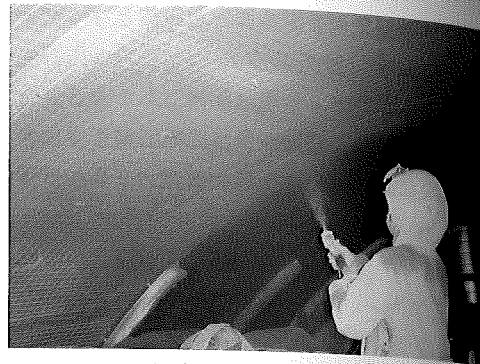
写真-10 吹付け状況
