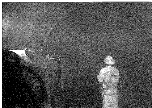
写真-1 通常の粉体急結剤吹付け状況
