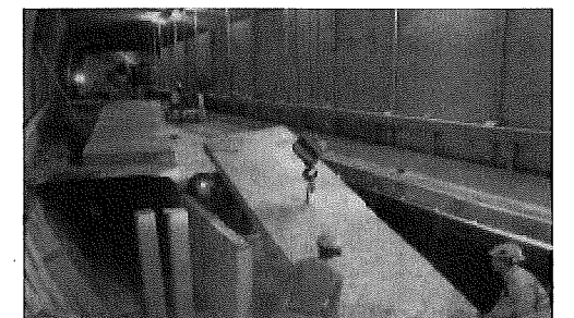
写真-2 床版の解体作業
