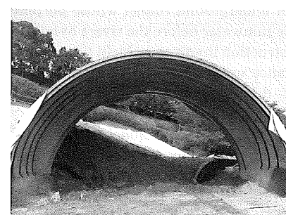
写真は本坑坑口付け状況(DⅢh3)
