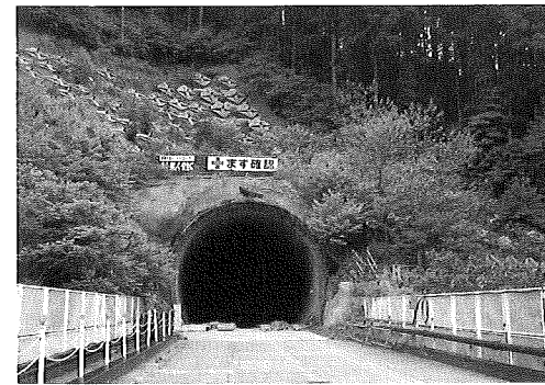
写真-3 歌トンネル東側坑口地すべり対策
