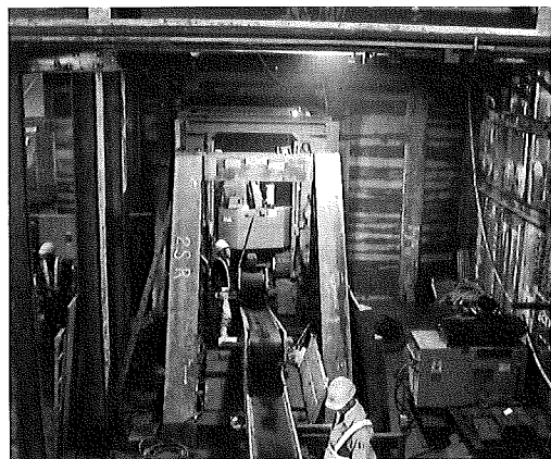
写真-1 導坑掘削状況
