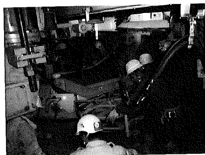
写真-5 搬送リール設置状況
