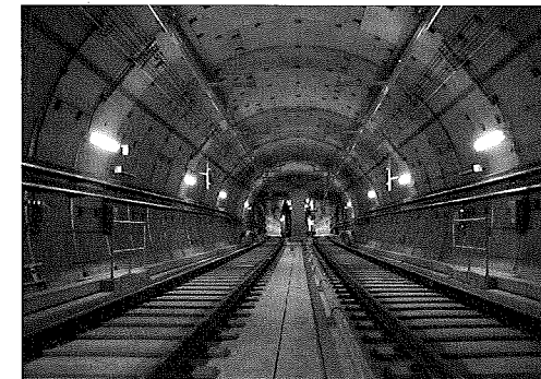
写真-5 トンネル全景
