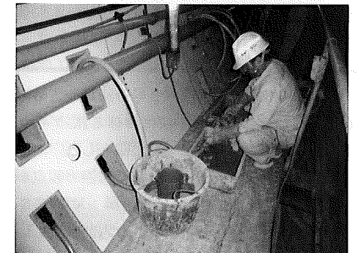
写真-6 PCグラウトの注入状況
