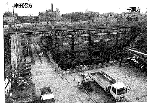
写真-3 JES函体完成
