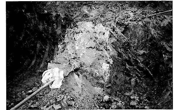
〈施工例〉固結状況
