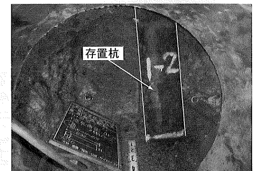
写真-1 存置杭撤去状況
