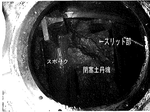
写真-5 切羽チャンバ内閉塞状況
