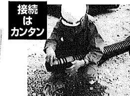
管路に継手差口をねじこみ
