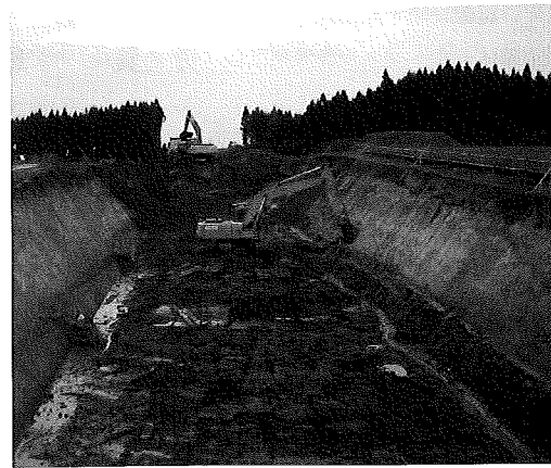
写真-1 開削施工状況
