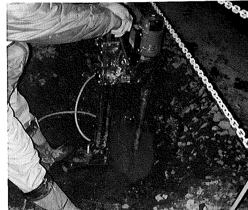
写真-4 パイロットホール削孔(インバート部の測定点)。 作業性は悪いが水中での計測も可能である
