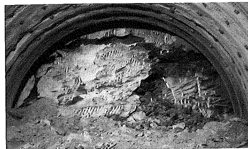
写真-1 切羽崩落状況(葉片状蛇紋岩)
