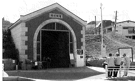
写真-1 アプローチトンネルの入口
