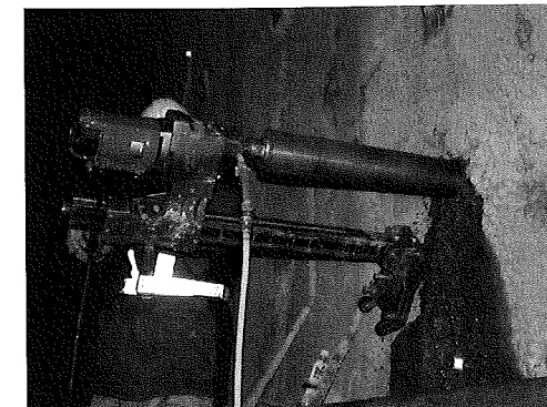
写真-6 オーバーコアリング(側壁部の測定点)
