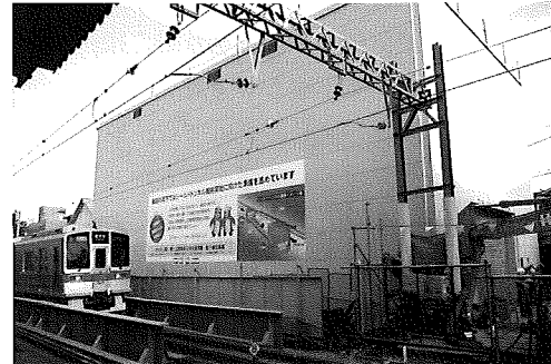
写真-6 工事騒音対策(防音ハウス設置)
