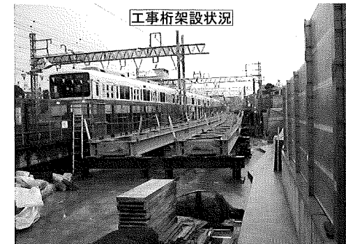
写真-2 現在進捗状況(土留め杭, 工事桁)
