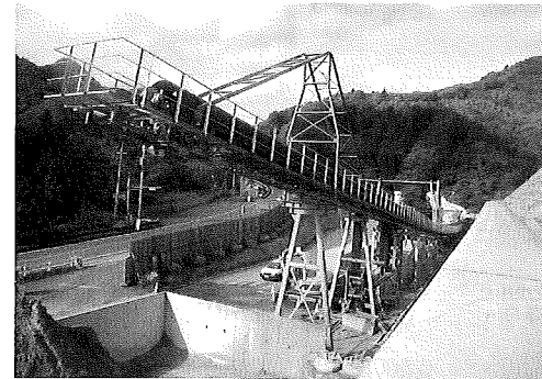
写真-2 坑外仮設備状況(坑口側)
