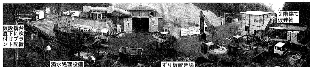
写真-1 仮設備配置状況全景
