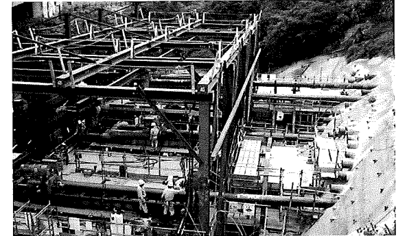
パイプルーフ打設状況(山岳トンネル)
