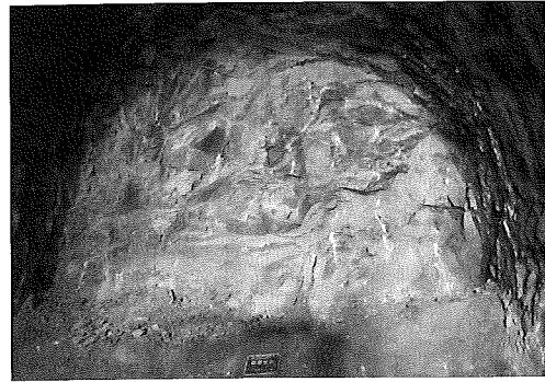
写真-1 梶原工区切羽状況(堅岩部)
