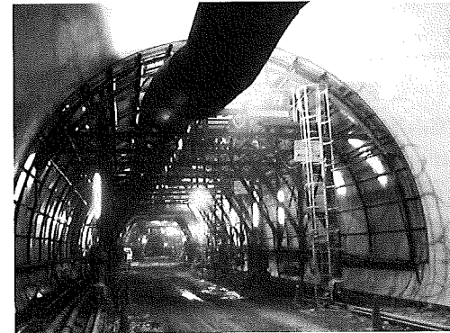
写真-2 システマチック養生台車(湿潤養生用)
