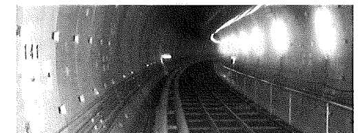
シールド坑内(180m付近)
