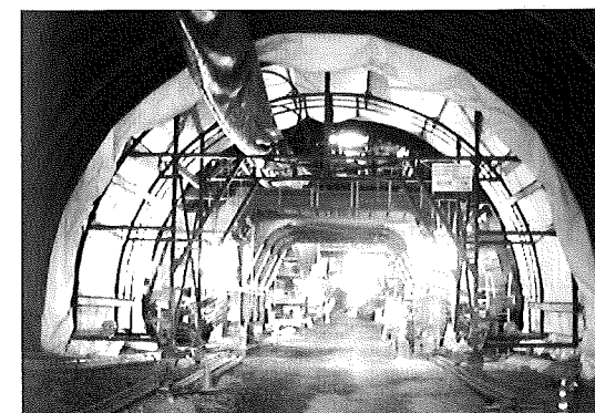
写真はシステマチック養生台車(封緘養生用)
