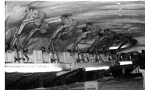
写真-12 防水シート張り機械施工
