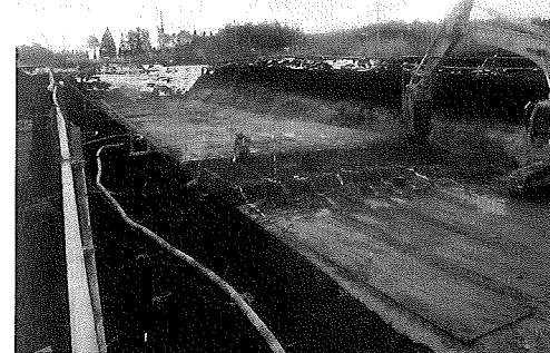
写真-3 改良状況
