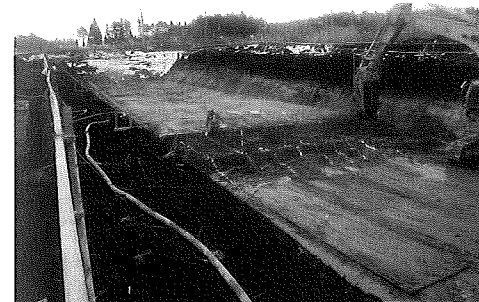
写真は改良状況
