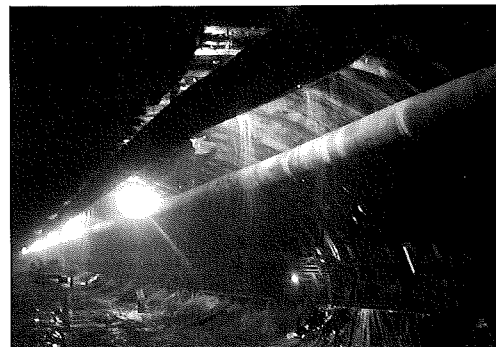
写真-5 湧水低減工施工前湧水状況
