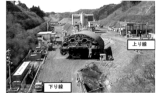
写真-14 大型アーチセトル移動状況
