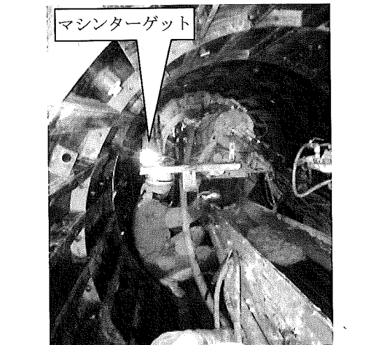
写真-3 マシンターゲット設置状況
