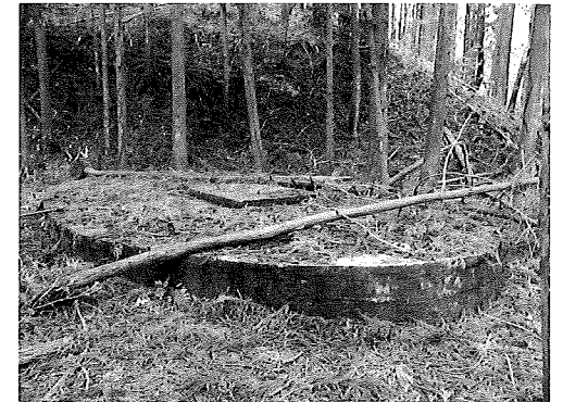
写真-2 立坑を塞いでいる蓋
