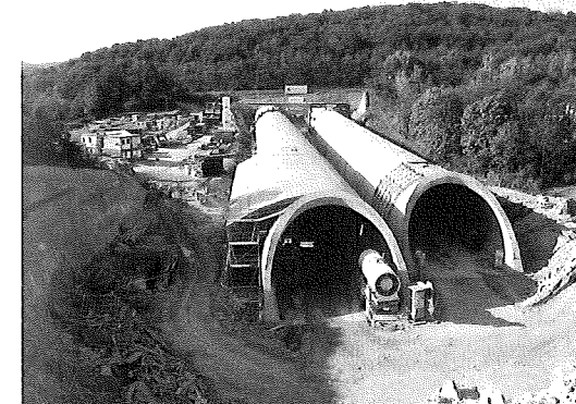
写真は北坑口(明かり巻き部と迎え掘り)
