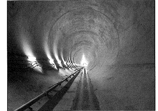
写真-3 上流導水路トンネルの二次覆工
