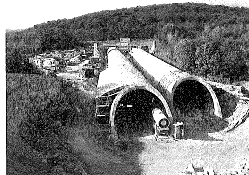
写真-3 北坑口(明り巻き部と迎え掘り2005年5月)
