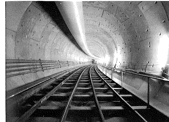
写真はRCセグメント区間施工完了状況
