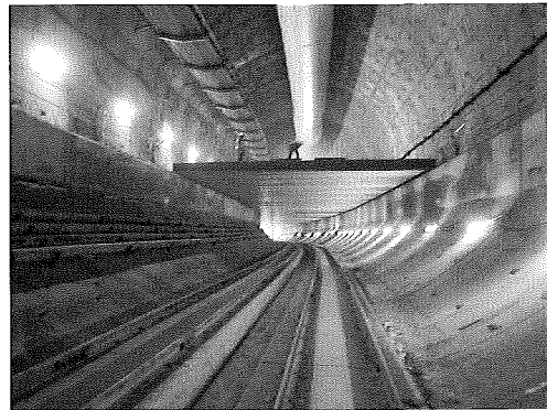
写真-12 床版の施工状況
