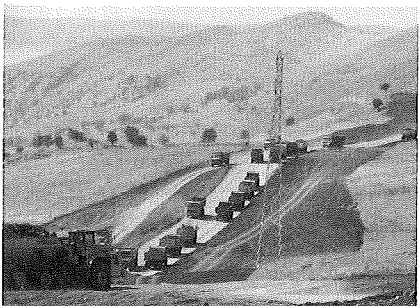
写真は明かり工場の施工状況
