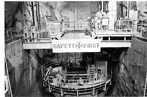
写真-2 圧力立坑上部昇降設備
