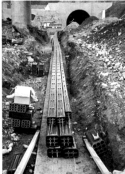
▲ 宇治トンネル (日本道路公団)
