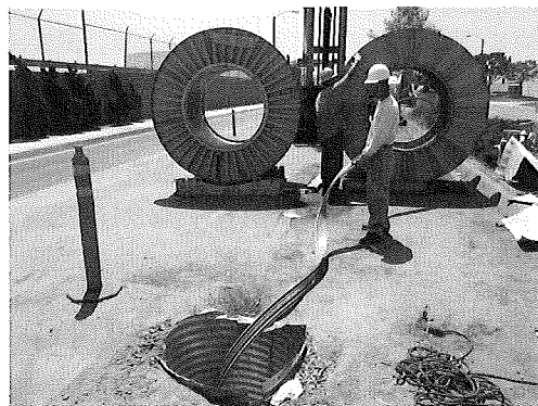
写真-4 仮設マンホールからのプロファイル供給
