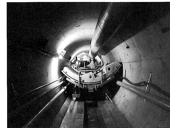
写真はコンパクトセグメントの搬送と仕上がり状況
