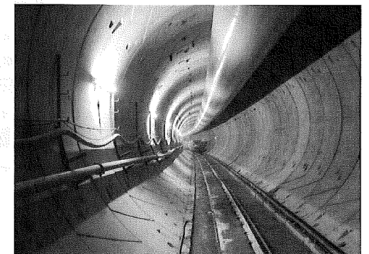
写真-1 導水路(TBM区間)
