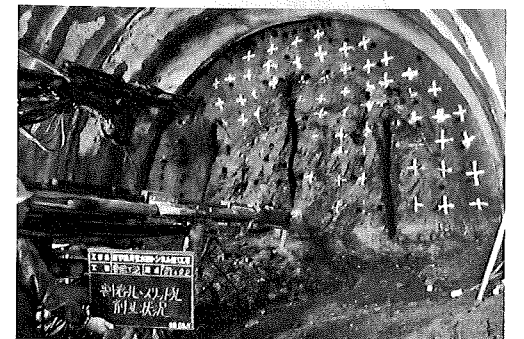
写真-5 スリット掘削状況
