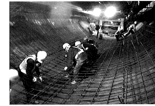
写真-7 インバート鉄筋
