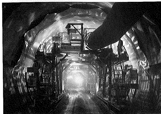
写真は防水シート施工状況
