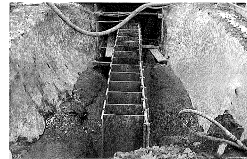
写真-6 H鋼鋼矢板土留め壁
