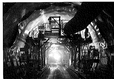
写真-9 防水シート施工状況
