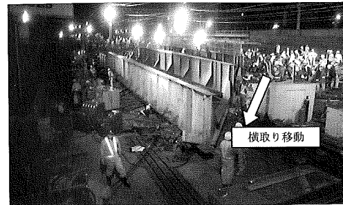
写真-2 既設桁横取り状況
