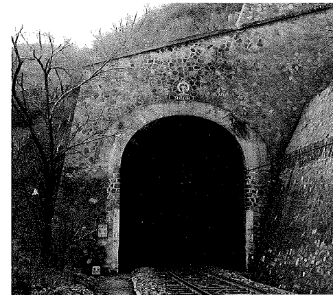
写真-2 解放後の複線化で完成した青竜橋二号トンネル
