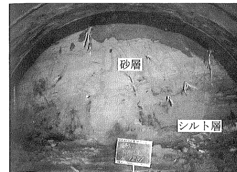
写真-3 流砂区間の切羽状況
