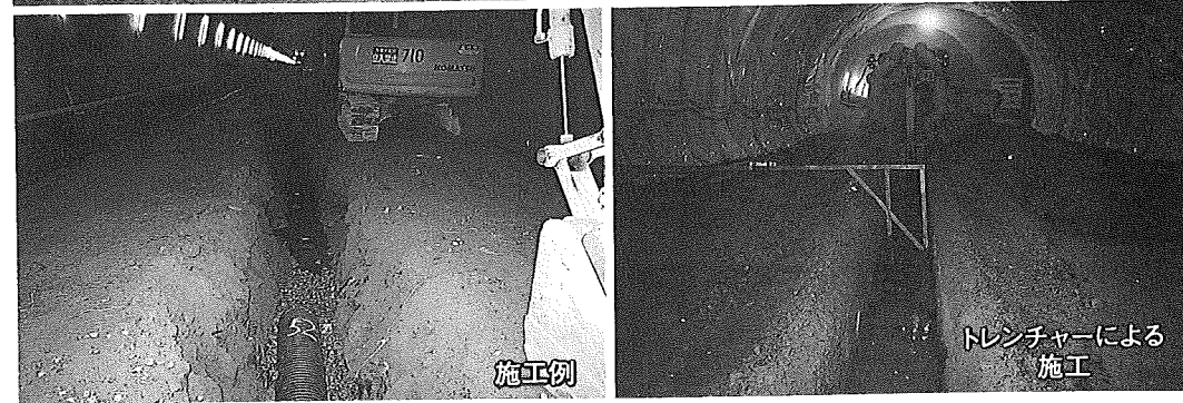
トンネル中央排水路掘削状況
