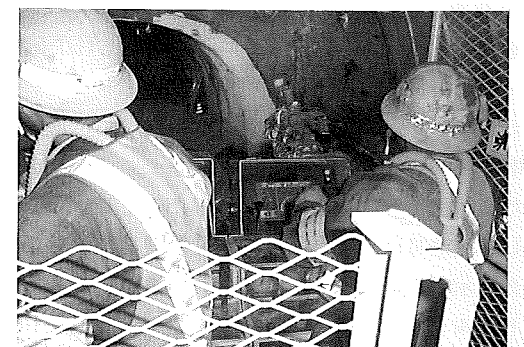
写真-5 ドリリングナビゲーションシステムによる穿孔作業
