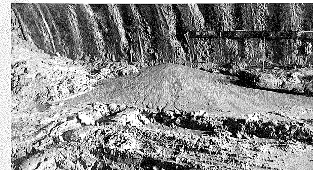
写真は砂の流出状況
