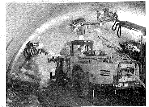
写真-9 上半SB孔穿孔状況
