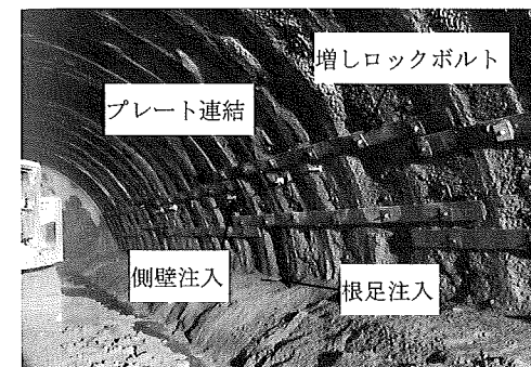
写真-4 補強工実施状況
