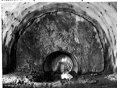
写真はスリット削孔後の切羽
