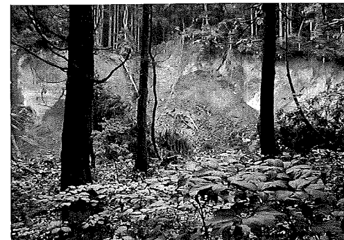
写真-2 上倉工区陥没部状況
