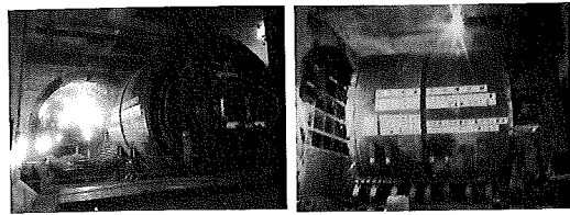
写真-3 シールドの再発進位置へのセット
