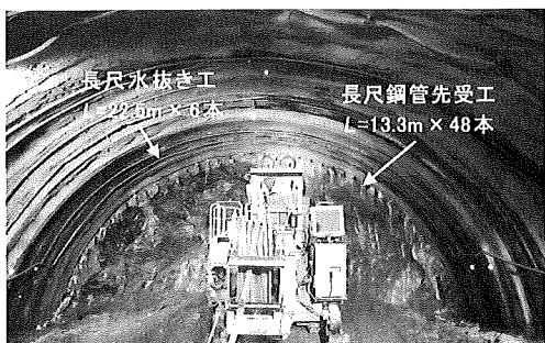
写真-4 上半掘削状況
