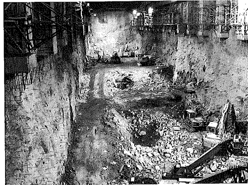
写真は地下発電所掘削
