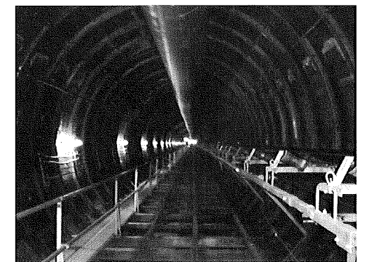
写真-3 開口拡張型鋼製ライナ(DII-T)
