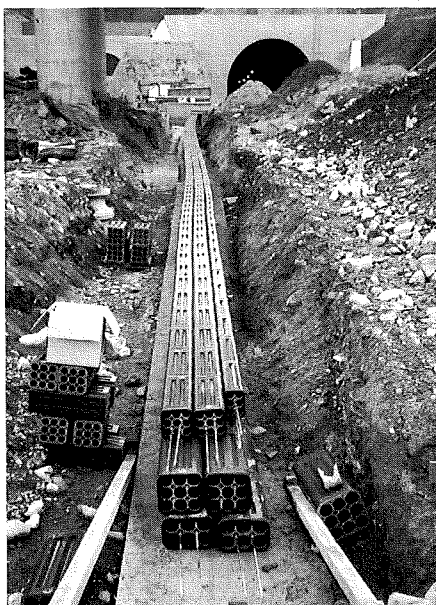
▲ 宇治トンネル [日本道路公団]
