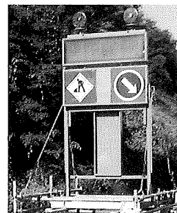
写真-1 仮設電光板
