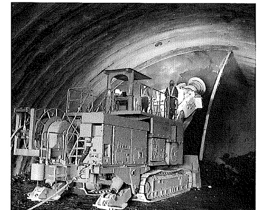
写真-2 自由断面掘削機による掘削状況
