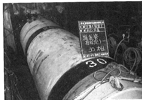
写真-7 施工状況
