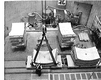
セグメント搬送状況(扇島工区)
