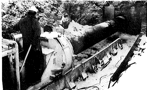
写真-2 掘削状況
