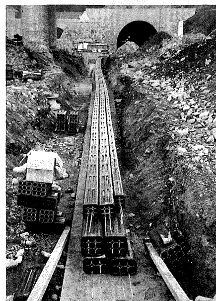
▲ 宇治トンネル [日本道路公団]
