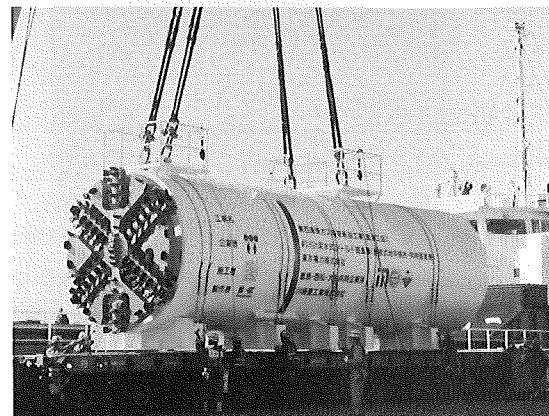
富津シールドの水切り状況
