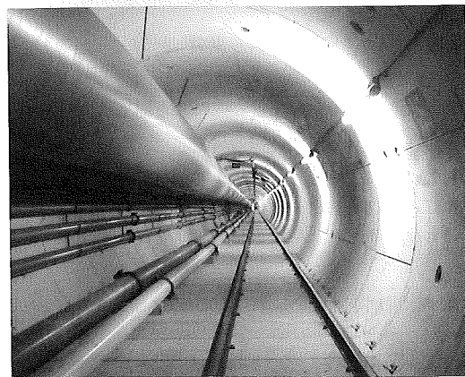
写真-1 坑内状況
