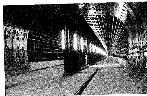
写真-4 坑内全景
