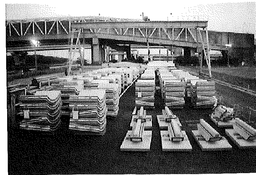
写真-1 地上ヤードと門型クレーン
