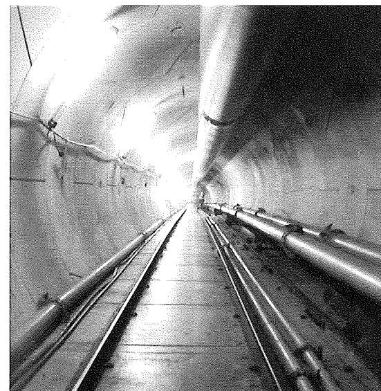
トンネル内の状況(扇島工区)
