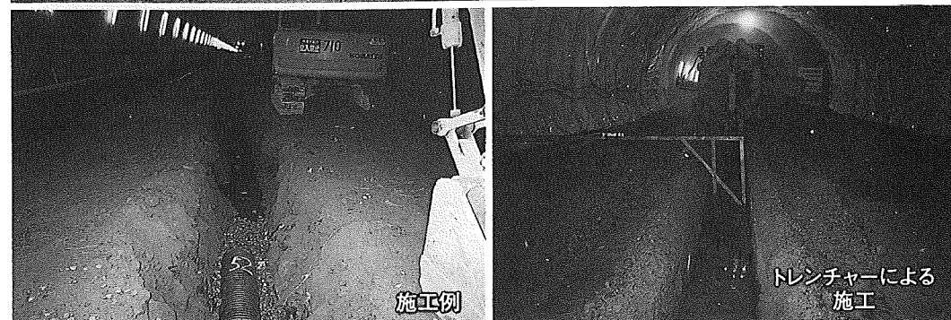
トンネル中央排水路 掘削状況
