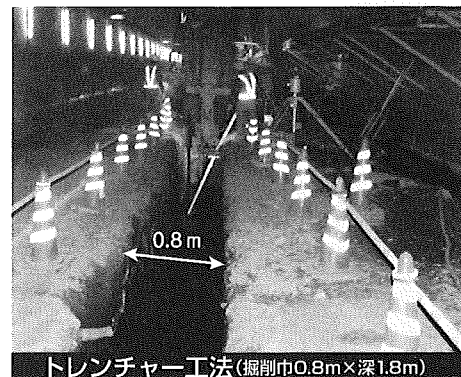
トレンチャー工法(掘削巾0.8m×深1.8m)
