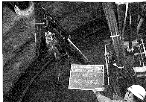
写真は長尺鏡ボルト(FIT)の打設状況
