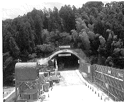
写真-1 久留米側坑口
