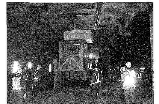
写真-2 撤去状況
