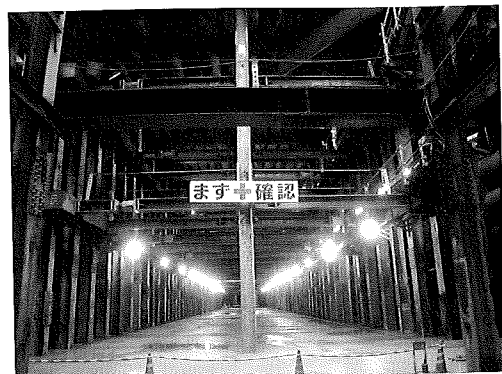
写真-12 掘削完了
