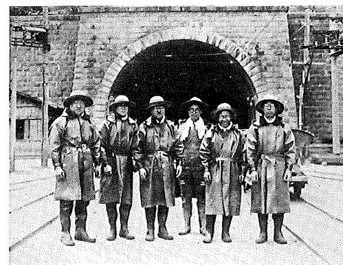
写真-3 丹那トンネル東坑口と平山復二郎(右から2人目)、『平山復二郎君の思い出』より
