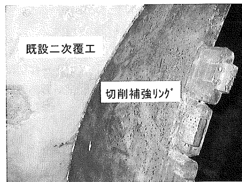
写真-6 切削補強リング(切削完了)
