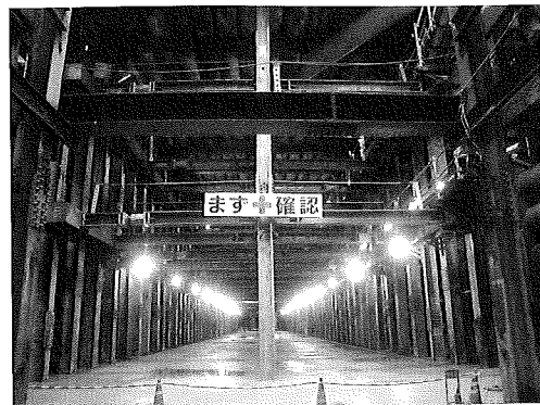
写真は掘削完了状況
