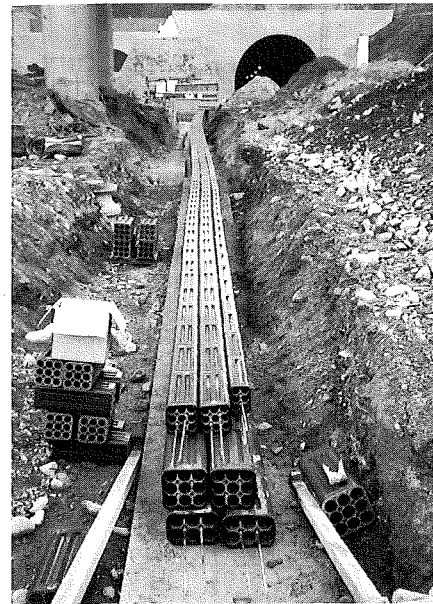
▲ 宇治トンネル (日本道路公団)
