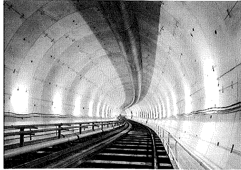
写真-5 トンネル内状況
