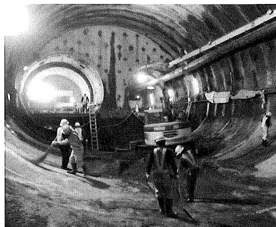
写真は移行部施工状況
