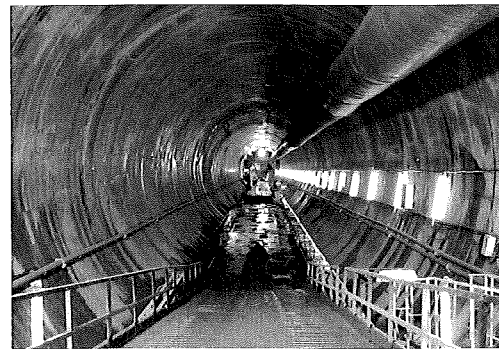
写真-3 場所打ちライニングの状況
