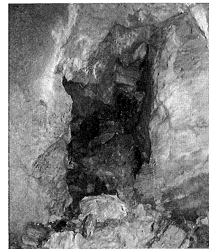
写真-3 H15.9.21横坑ぼらの状況
