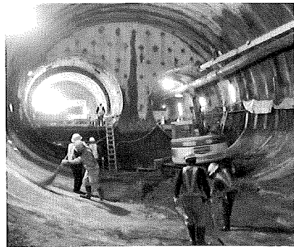
写真-3 移行部施工状況
