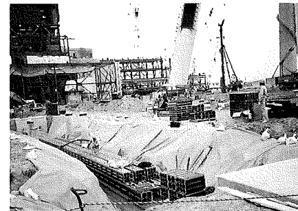
▲ 川越火力発電所 (中部電力株)
