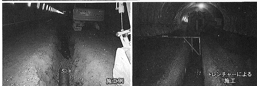
トンネル中央排水路掘削状況
