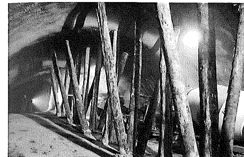
写真はバルクヘッド設置状況
