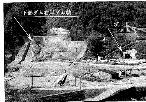
写真-1 放水路トンネル坑口
