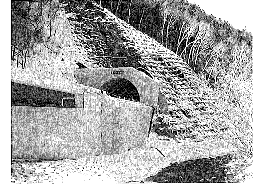
写真-3 トンネル坑口部の全景(2005年2月)
