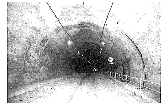
写真-3 木沢トンネルの被害状況(側壁部からアーチ部のひび割れ)
