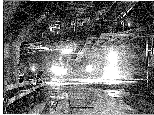
写真-13 本坑交差点部
