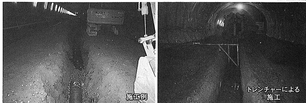
トンネル中央排水路 掘削状況
