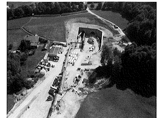
写真-8 坑口付近の仮設備状況
