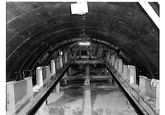
写真-9 TBM掘削による坑内状況
