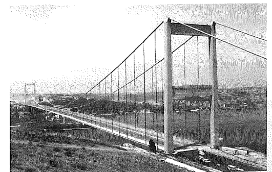
写真-2 第2ボスポラス橋
